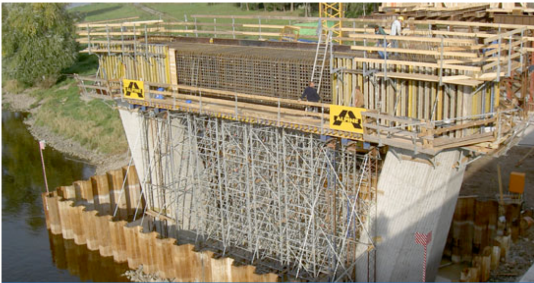
Ejecución de las obras del puente
